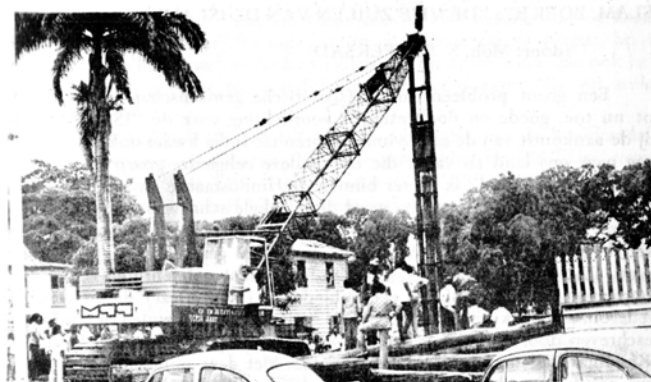
De machine van N.V. Exploitatie Mij bezig met het heien van de eerste paal. Dokter Jamaludin verlaat de cabine.
