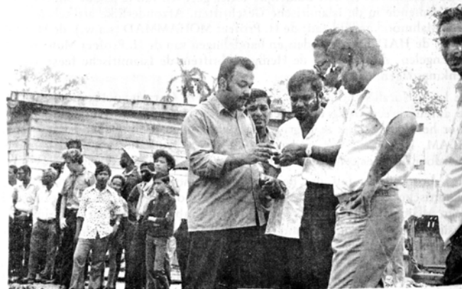
De heren Noermohamed, Ir. Ataoellah, Ir. Soerdjoesing en Ir. Jankipersadsing bij elkaar om zich te beraden over de diverse constructie-werkzaamheden.
