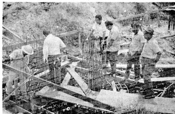
Controle van de bewapening van de „Minaarut-fundering“. Van rechts naar links op de foto de heren: M.A. POESA (aannemer); Ir. N. ATAELLAH (voorz. Bouwcommissie); Ir. E. NOERMOHAMED en Ir. G.D. SOERDJOESING (techn. Adviseurs).
